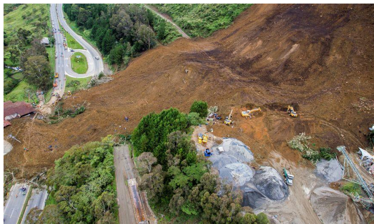
Slika 10 - Klizišta i odroni
